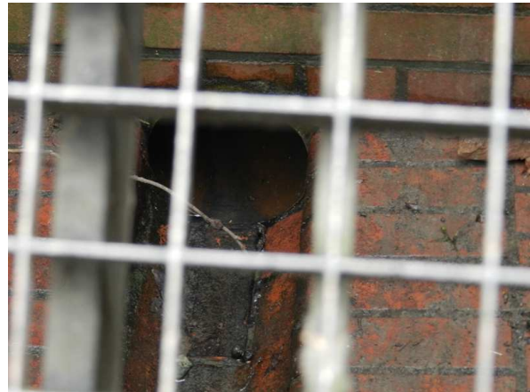
Foto 2: Der Rohrdurchmesser im Bauwerk beträgt ca. 20 cm. Wasserführung am 26.02.2012 ca. 0,1 l/sec.
