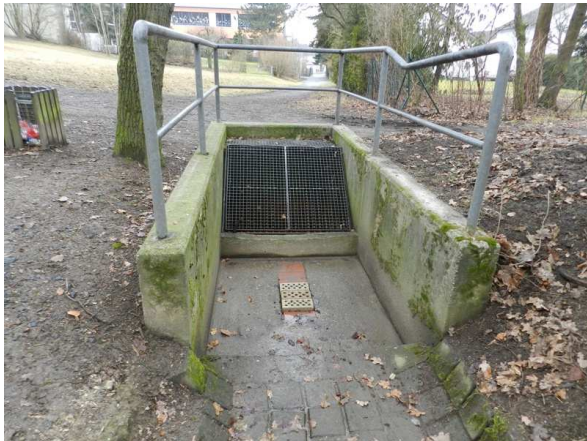
Foto 1: Blick auf das naturferne Einlaufbauwerk der Verrohrung des Braubaches (26.02.2012).
