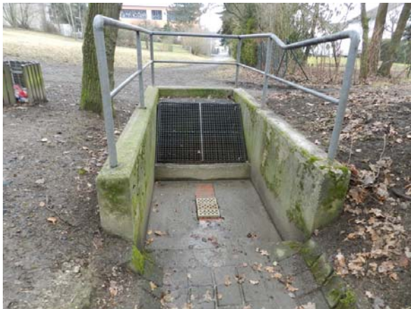
Foto 17: Naturfernes Einlaufbauwerk der Verrohrung des Braubach im Feb. 2012.
